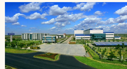
3. 特变电工能源(印度)公司特高压变压器厂房项目(机械工业优秀工程设计三等奖);
