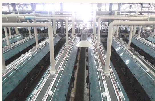
5. 骆驼集团华中蓄电池有限公司年产 400 万 kVAh 新型低铅耗免维护蓄电池项目(国际工程公司优秀科技成果一等奖);
