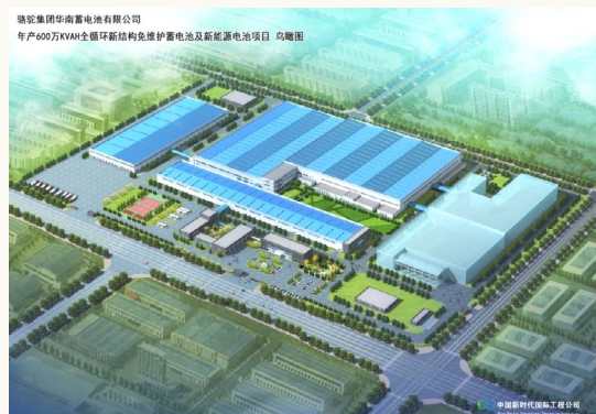
11. 骆驼集团华南蓄电池有限公司年处理15万吨废旧铅酸蓄电池建设项目(陕西省工程咨询三等奖);
