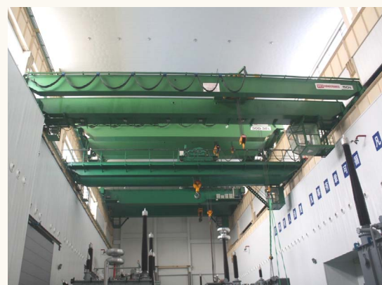
10. 特变电工衡阳变压器有限公司特高压厂房接建项目(国际工程公司优秀科技成果二等奖);
