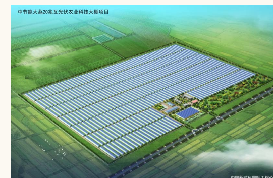
14. 中节能大荔农业科技大棚 20MWp 光伏电站项目(国际工程公司优秀科技成果二等奖);
