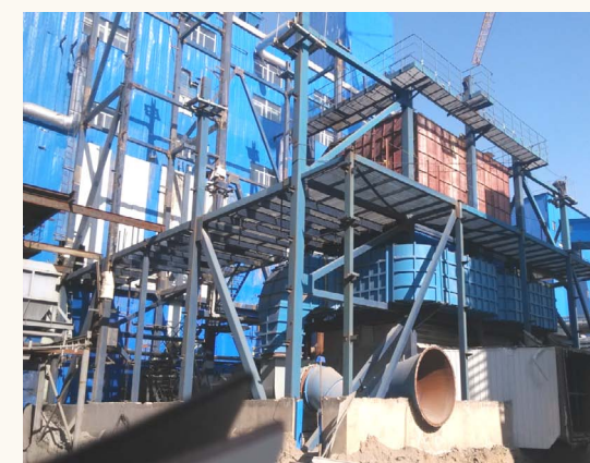
15. 内蒙古鑫旺再生资源有限公司 2×240t/h 煤粉锅炉脱硝改造工程项目(国际工程公司优秀科技成果二等奖);
