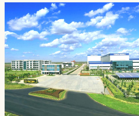
11. 特变电工能源(印度)公司特高压变压器厂房项目(国际工程公司优秀科技成果二等奖);
